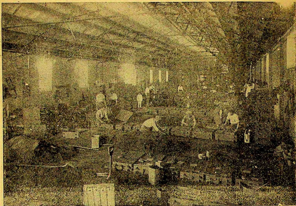
Vista del interior de la fábrica de máquinas agrícolas de Francisco Carelli, en Venado Tuerto
