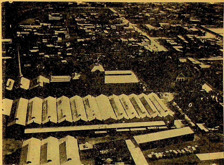
Cervecería Santa Fe S. A. — Vista aérea completa, con las perspectivas del Canal de Derivación. — Santa Fe
