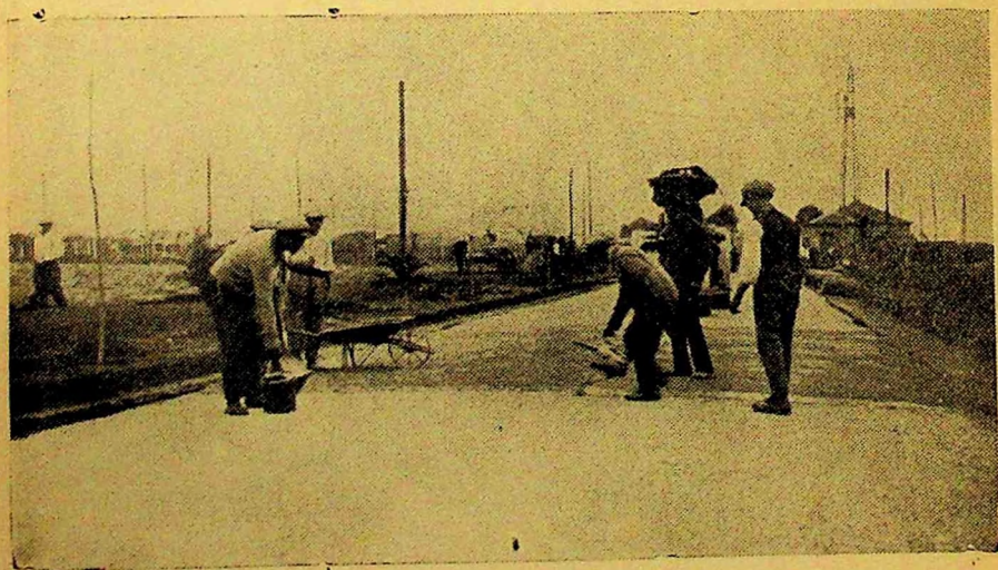
Bugnone, Guida y Compañía, Rosario — Construcción de pavimento de macadam asfáltico
