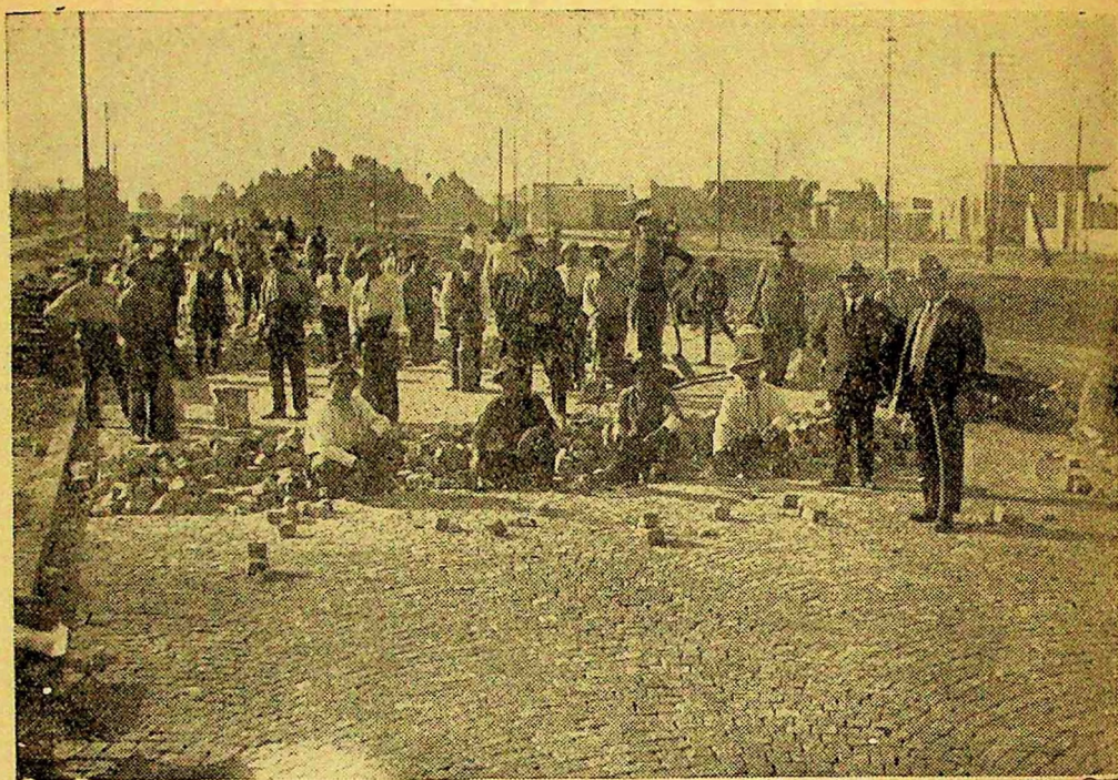
Empresa Bugnone Guida y Cía. — Construcción de pavimento de granitullo. — Rosario.
