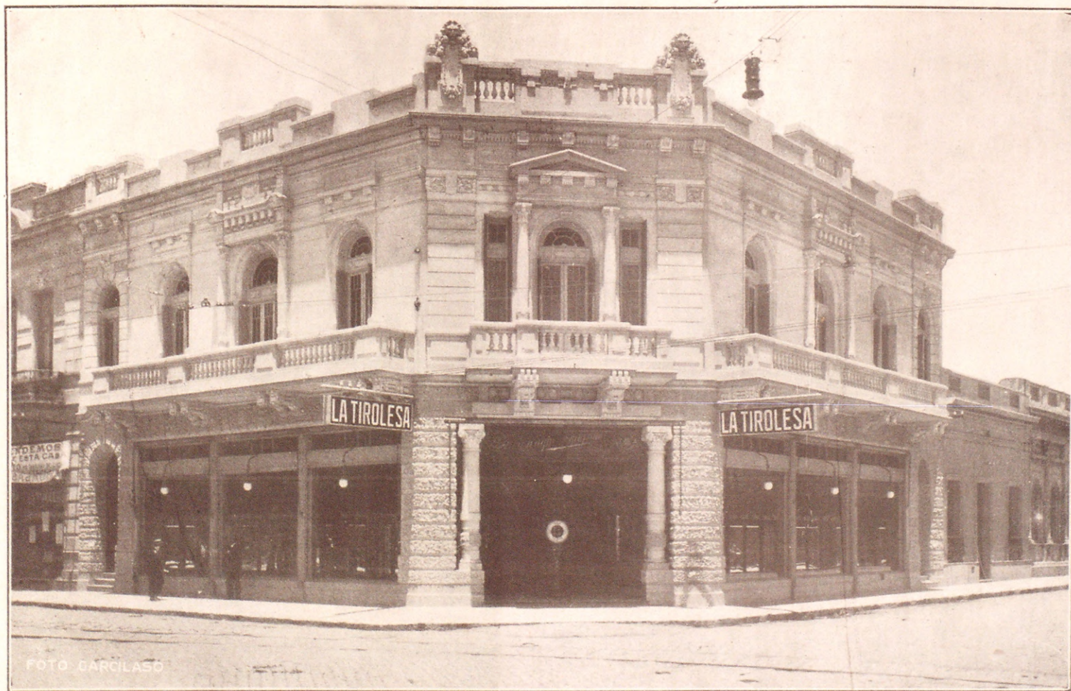
Edificio de la Tirolesa
